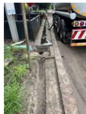
รูปที่ 24 รางรับน้ำรอบพื้นที่กักเก็บน้ำมัน
