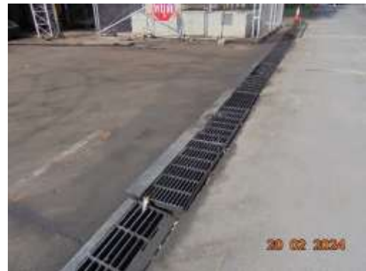
รูปที่ 22 รางระบายน้ำรอบกองเหล็ก
