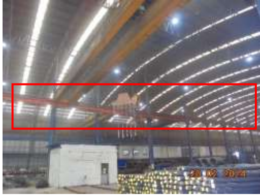
รูปที่ 58 รางเดินระบบไฟฟ้า
