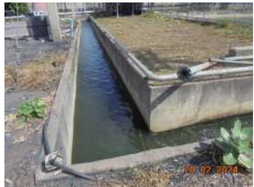
รูปที่ 10 รางระบายน้ำหล่อเย็น
