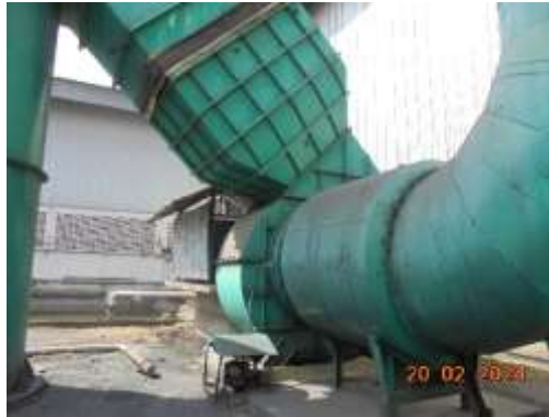
รูปที่ 32 ระบบเก็บเสียง (Silencer)
